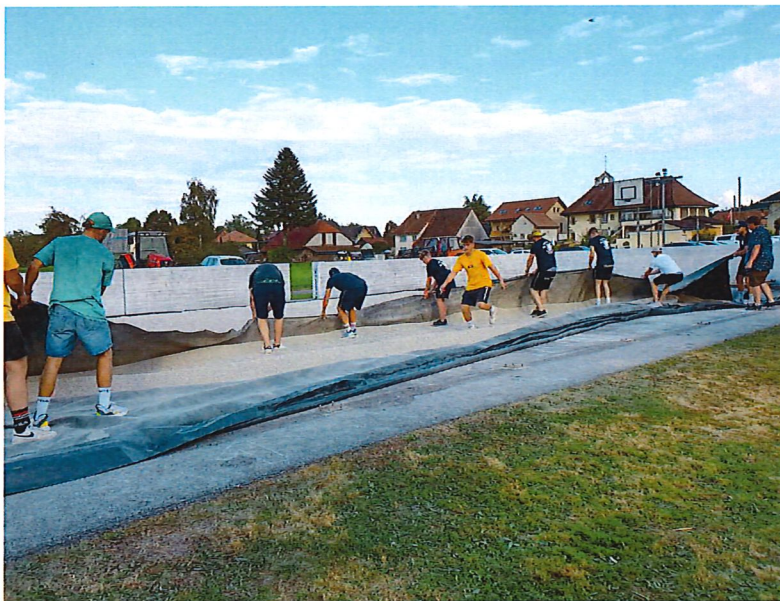
Teamarbeit sowohl bei der Montage als auch bei der Demontage.
