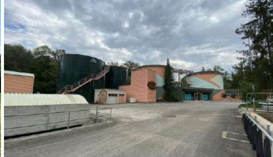
Vue depuis la STEP vers le nord-ouest
